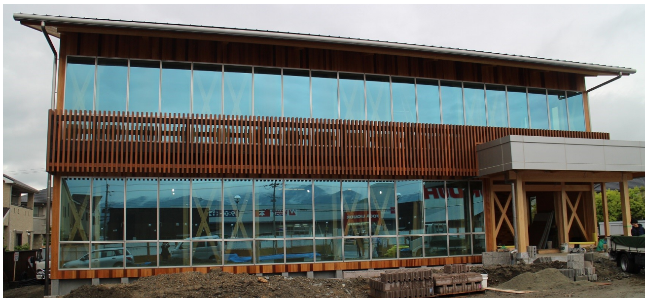
5月22日の竣工にむけ建設中の桜井木材協同組合会館
