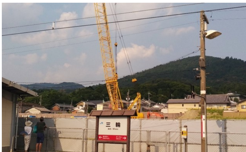
JR三輪駅東側での大神神社「直会殿・能楽堂」の建設現場
