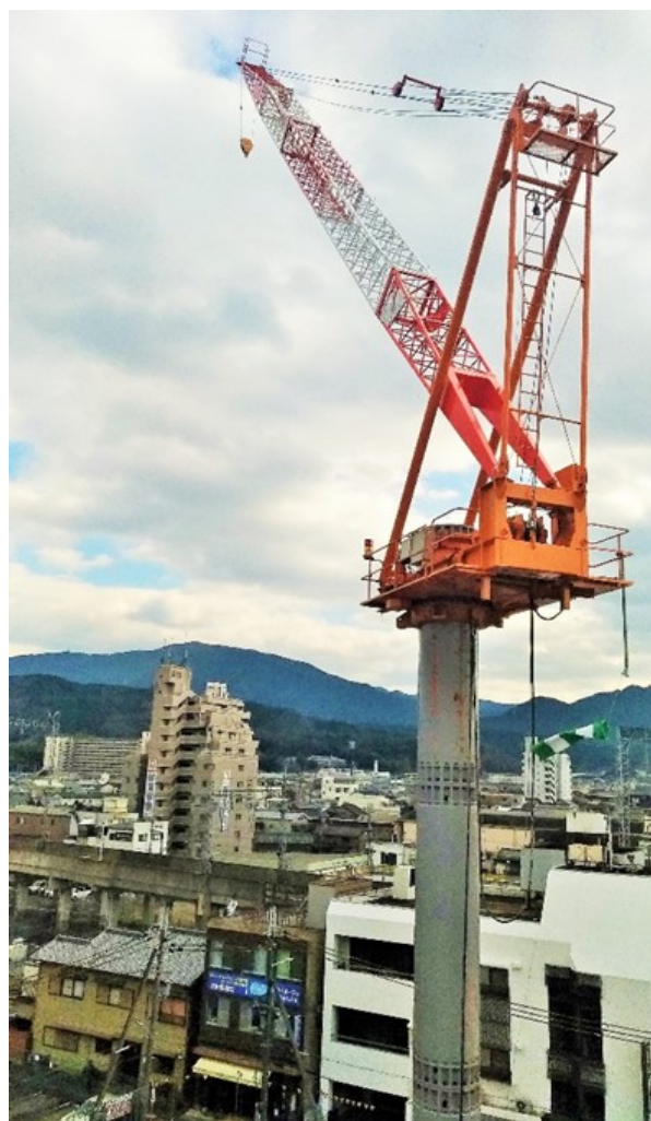
桜井駅北口東側のホテル新設現場
