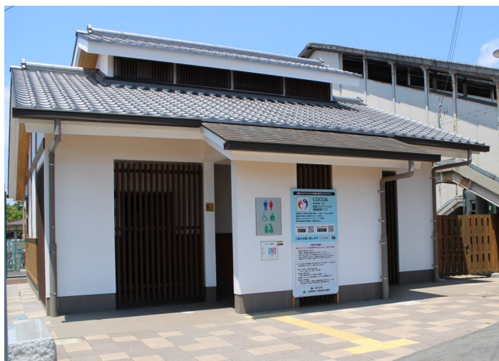
JR三輪駅前公衆トイレ
