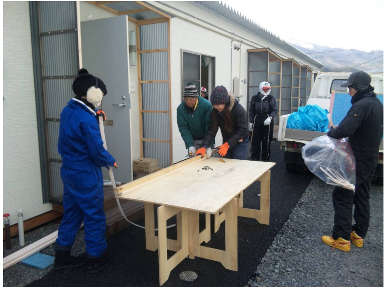
仮設住宅での作業風景
