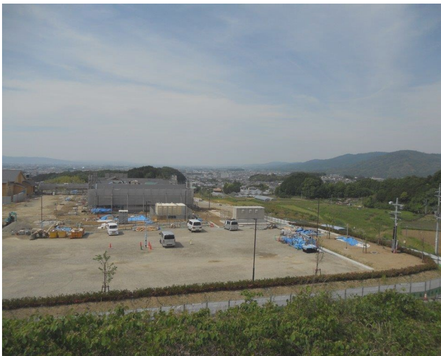
建設中の「なら食と農の魅力創造国際大学校」
